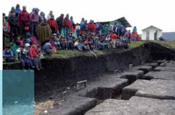
Construcción cimientos escuela Alausí, Ecuador.
