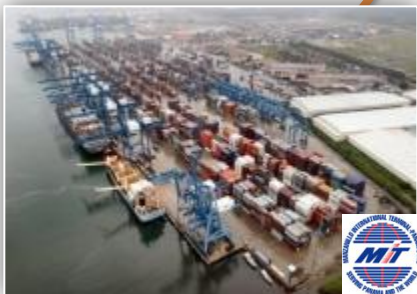
Manzanillo International Terminal (MIT)
