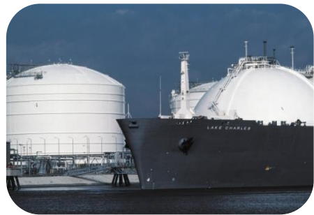
Terminal de LNG
